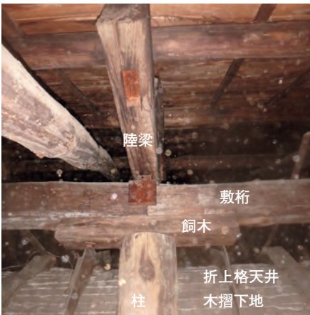
写真 14 身舎の軸部（中央丸柱柱頭部）
