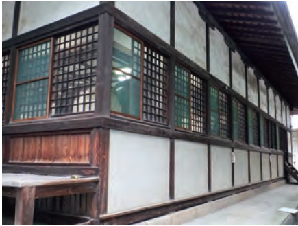
写真 23 現況 東面外壁
