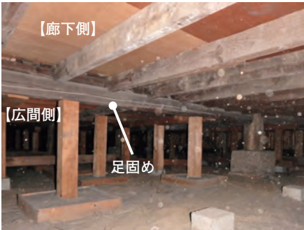
写真 12 廊下と広間境の足固め
