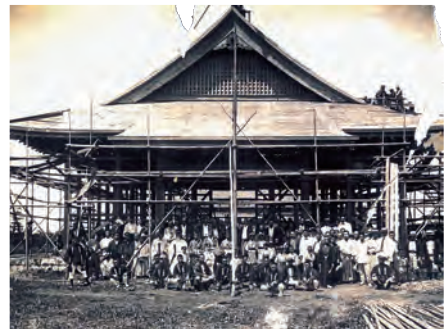
写真29 1919年7月27日 大講堂上棟式(正面)
