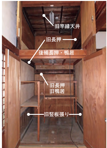
写真 68 現状 北西側物置 (内部)
