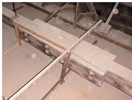
写真 19 陸梁の継手部分
