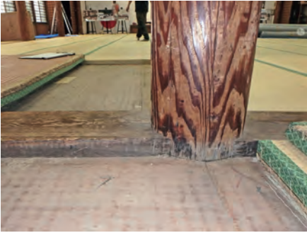
写真 54 現状 広間境廊下側の無目敷居
