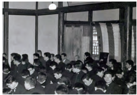
写真 65 1961年 折れ戸が設えられた北東物置
