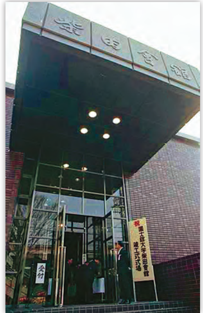
1983年4月 柴田会館竣工
