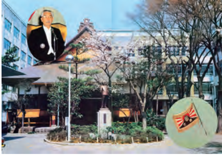
写真 36 1982 年頃 銅板葺き屋根 （『体育学部第 24 回卒業アルバム』1983 年 3 月）
