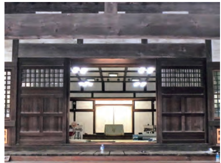
写真 26 現況 正面出入口の框戸
