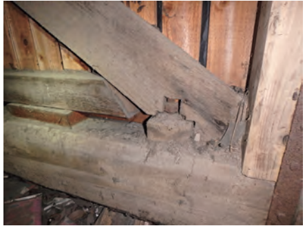
写真 9 土台アンカーボルト
