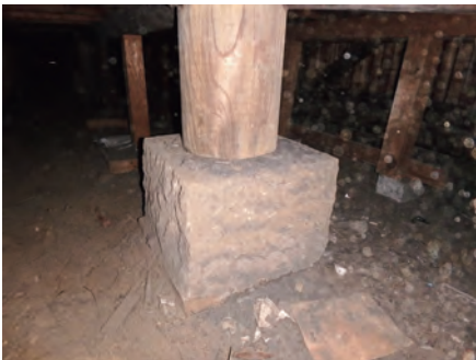
写真8 内部柱 (石場建て)
