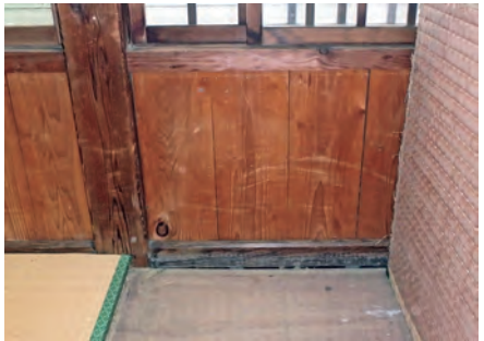
写真 55 現状 廊下巾木
