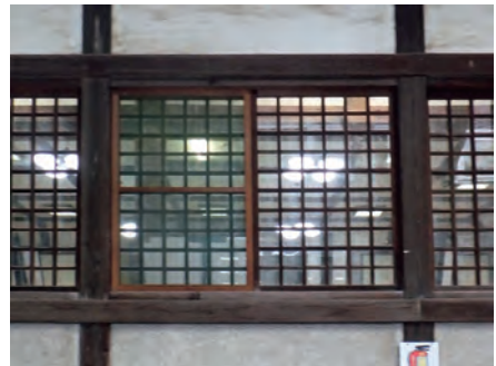
写真 27 現況 廊下のガラス窓
