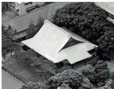
写真 34 1959年 世田谷校地全景写真(拡大)
