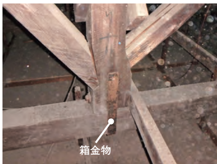
写真 18 対束と陸梁を繋ぐ箱金物
