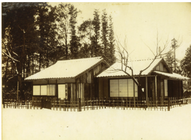
景 松 塾 (昭和 13 年 12 月 7 日竣工)
