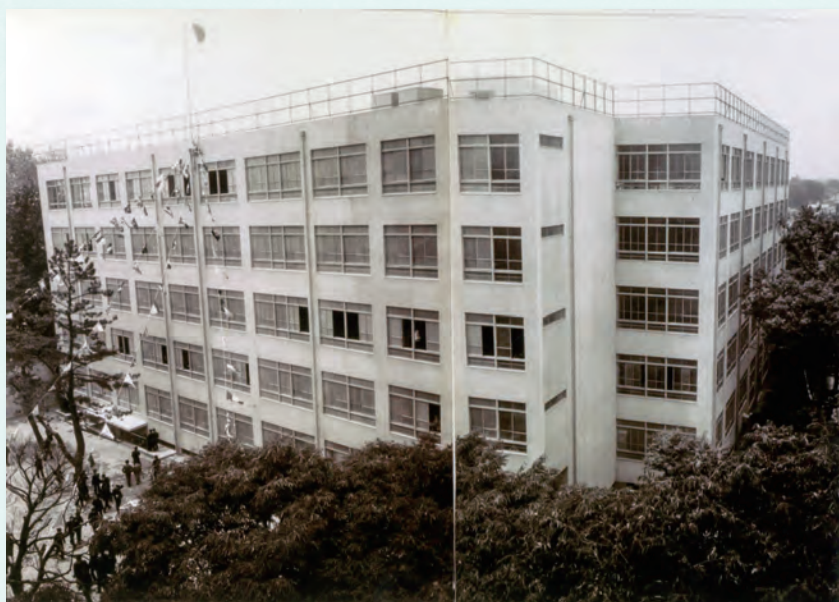
中学校高等学校校舎8号館 (1964年)
