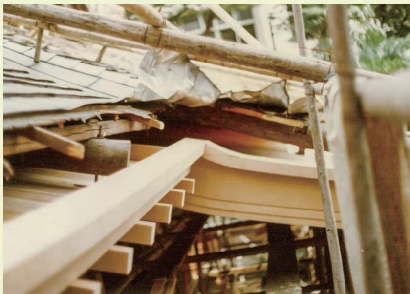
1958年に葺き替えた金属板(アルミ合金)葺の屋根
