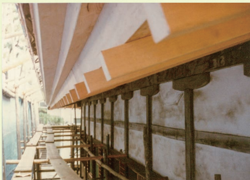
新しくなった屋根を支える軒先の材木
