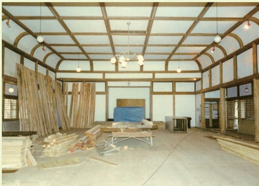
工事中の堂内
