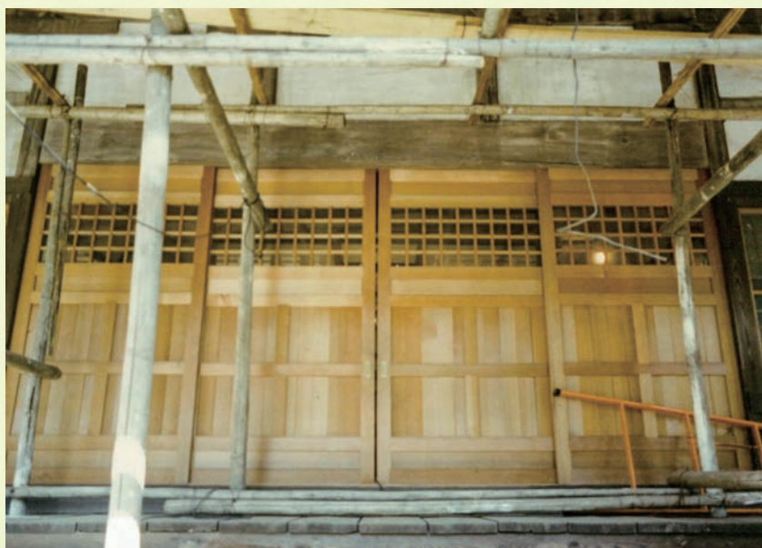
大屋根葺替に先立って新調した正面戸
