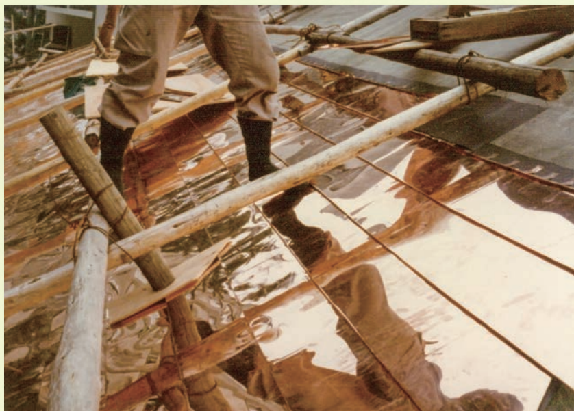
新たに銅板葺きとなった大屋根
