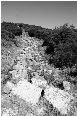
図15 フィガリアの北東部の囲壁の内外石材の組み合わせ（熊本大学メッセネ・フィガリア調査隊）
