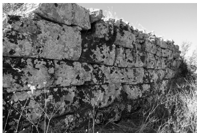
図22 メッセネのイトーメ山頂の整層積みの擁壁
