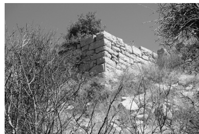
図23 同左の非整層積みの囲壁
