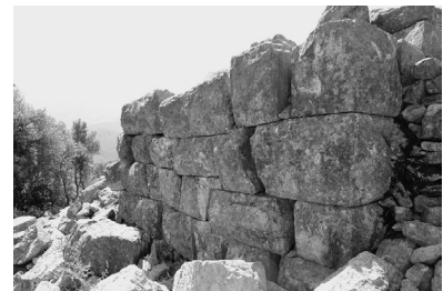
図12 フィガリアの北東部の「切り出し仕上げ」の石材による囲壁 (熊本大学メッセネ・フィガリア調査隊)
