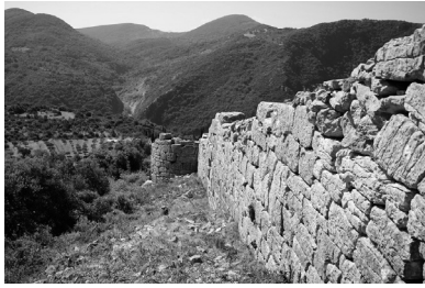
図13 フィガリアの北東部の「つち仕上げ」の石材による囲壁
