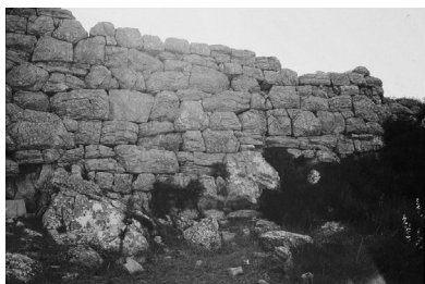
図27 ティソーアの非整層積みの囲壁
