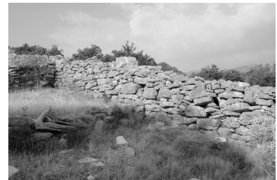
図10 同左の非整層積みの囲壁 (同左)
