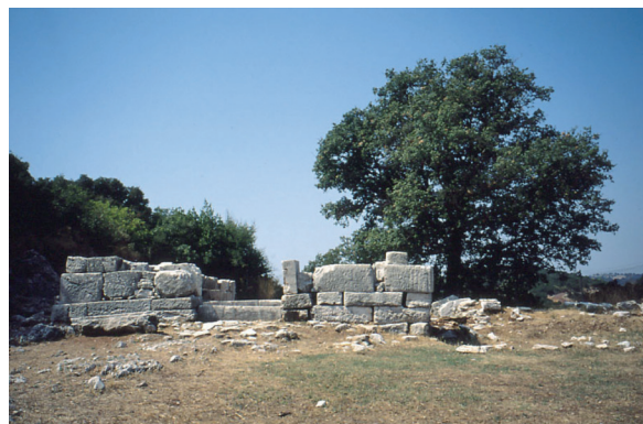
図43 「アテナ・ポリアス及び安泰加護のゼウス両神の神殿」の東正面
