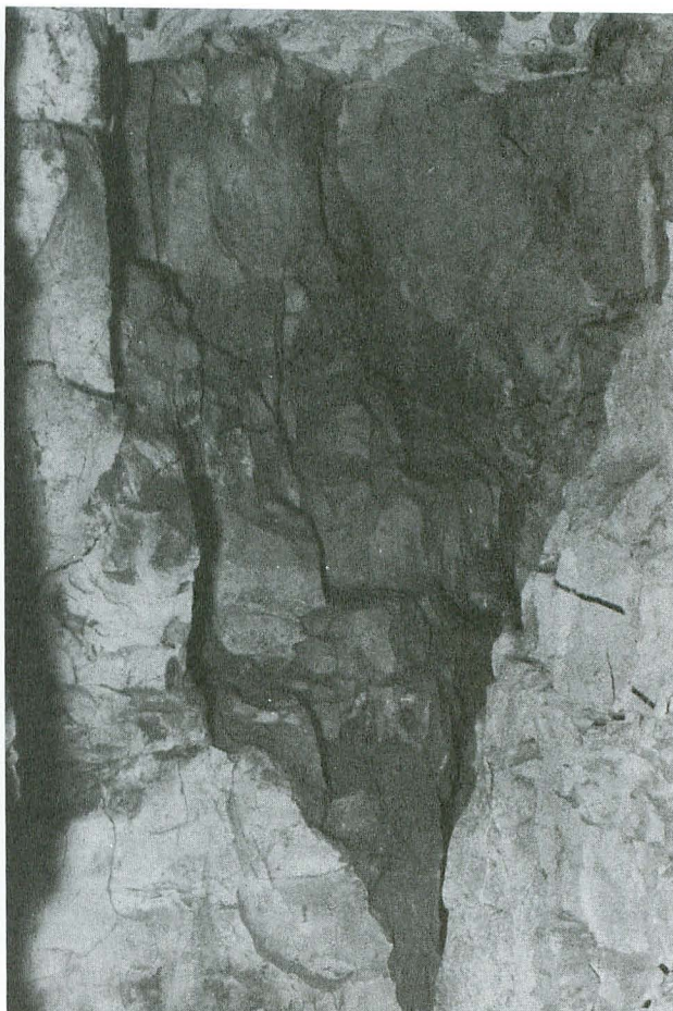
b. R3 の掘削状況
