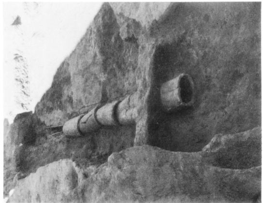
3 排水管 Drain Pipe
