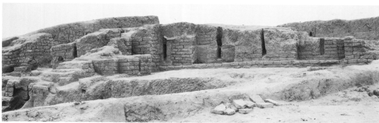
3 II層 遺構 東より Wall Structure, Level II, from the East
